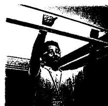
照明器具の交換
